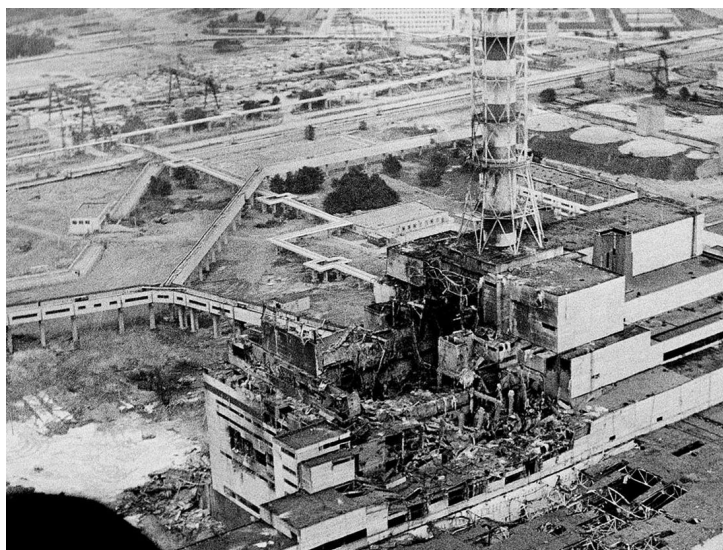
Obrázek 1: Poškozená budova čtvrtého bloku jaderné elektrárny Černobyl
