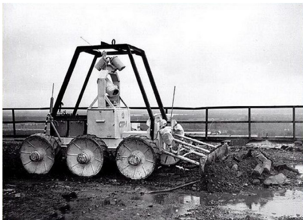
Obrázek 2: Robot STR-1 při práci na střeše elektrárny
